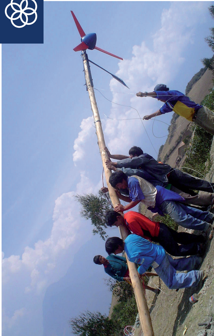
Fot. 17. Instalowanie turbiny wiatrowej, Peru. Practical Action
